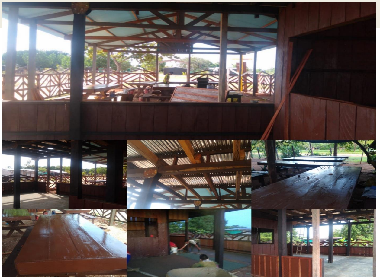
Cantina : travaux de construction de la cantine à Puerto Carreño.
